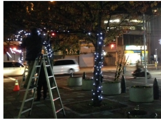
取り付け作業中
